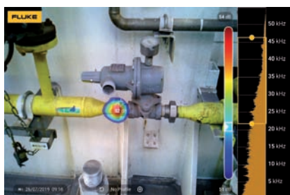
Presné určenie miesta úniku plynu – indikácia netesnosti v prírubovom pripojení
