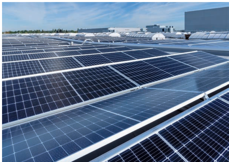
Na streche Factory 56 je fotovoltaický systém, ktorý zásobuje budovu zelenou elektrickou energiou z vlastnej výroby.
